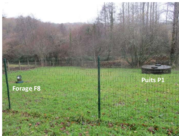
Figure 15 : Vue du forage F8 et du puits P1 actuels
